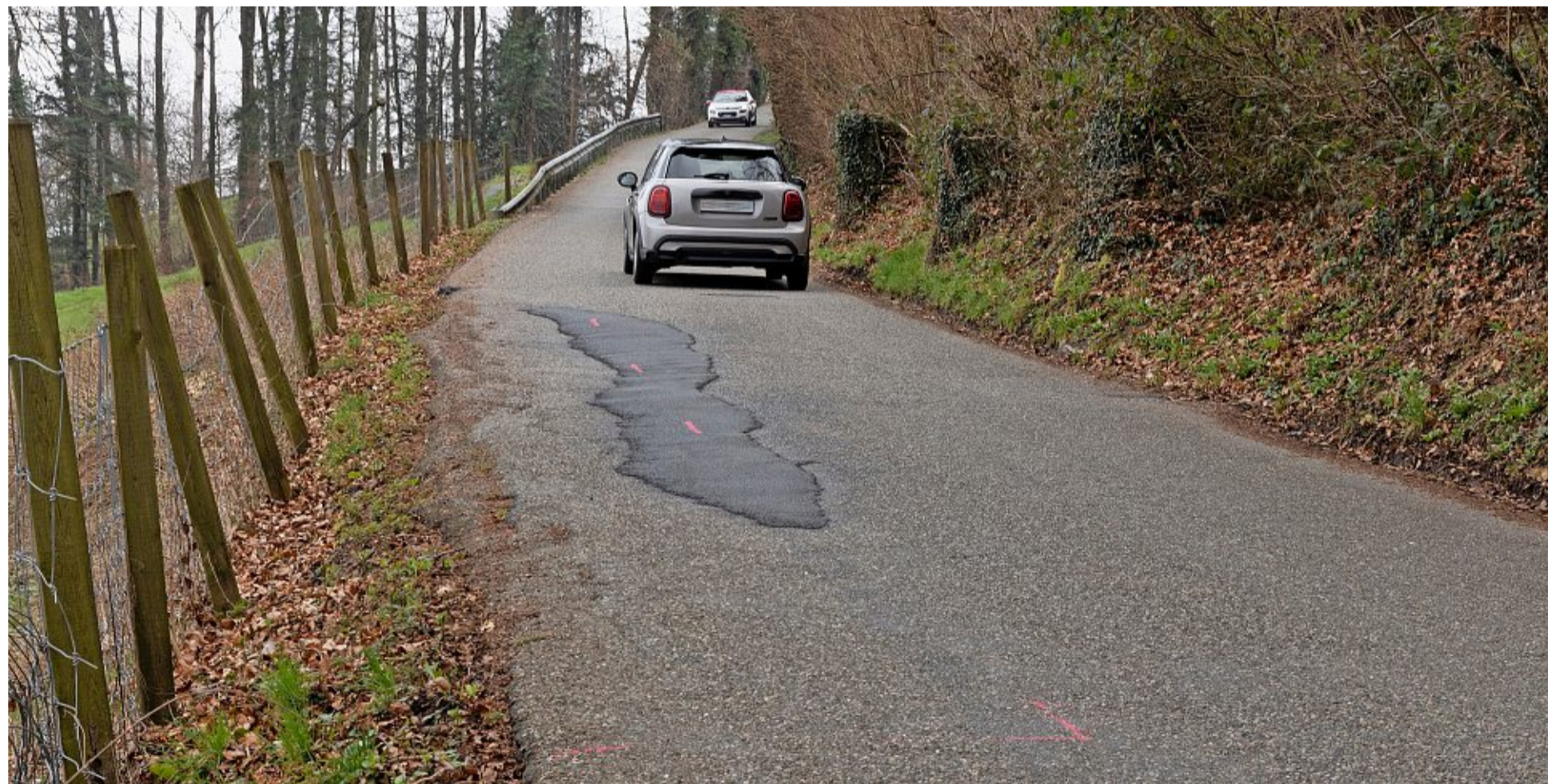
Der schlechte Untergrund und der Verkehr führten dazu, dass die Unterortstrasse abgerutscht ist. Foto: Sabine Rock
