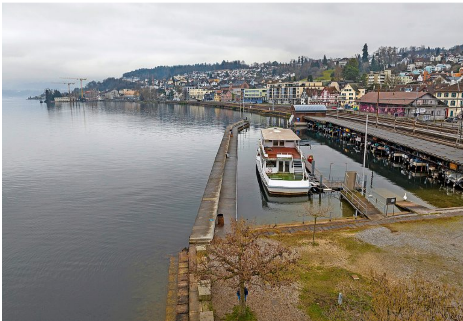
Der neue Seeuferweg wird vom Seeplatz bis zur Halbinsel Giessen führen, wo Baukräne zu sehen sind. Er wird hinter dem bedeckten Bootshafen und dem anschliessenden Seerettergebäude (mit halbrundem Dach) durchführen. Foto: Michael Trost
