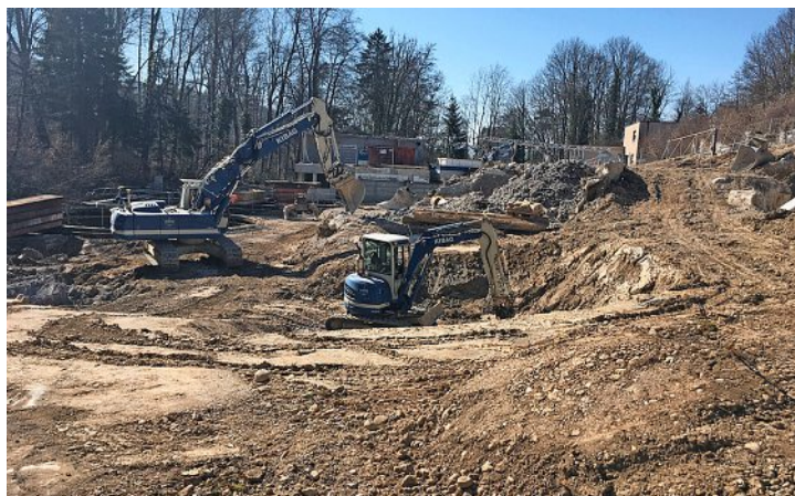
Die Bagger haben einen Grossteil der ARA abgetragen. Als Nächstes wird neues Erdreich auf dem Gelände verteilt. Foto: PD
